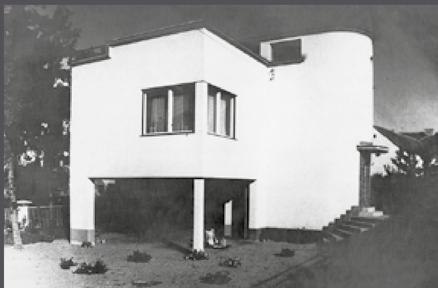
Építészetének egyik legszebb megnyilvánulása az 1933-ban felépült saját lakóháza, aszimmetrikus szerkesztésű, lapostetős modern villa a Várkörút 11. sz. alatt.
