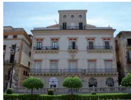
A palota a felújítási munkák után.
