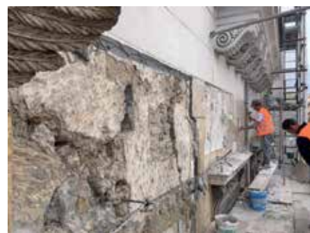
A leváló falazati és vakolati részek eltávolítása, valamint az aljzat tisztítása után a homlokzat SILANCOLOR BASE COAT-tal és SILANCOLOR PITTURA PLUS-szal lett lefestve és megvédve.
