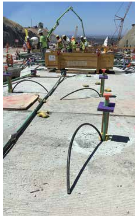
A betonacélrudak és a furatok fala közti rés kitöltése MAPEFILL habarccsal.
