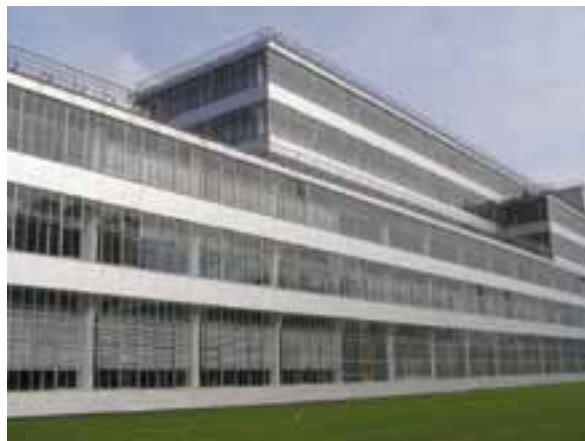
A hajdani Van Nelle gyár újrahajósítása, Rotterdam. Építész: Vessel de Jonge
