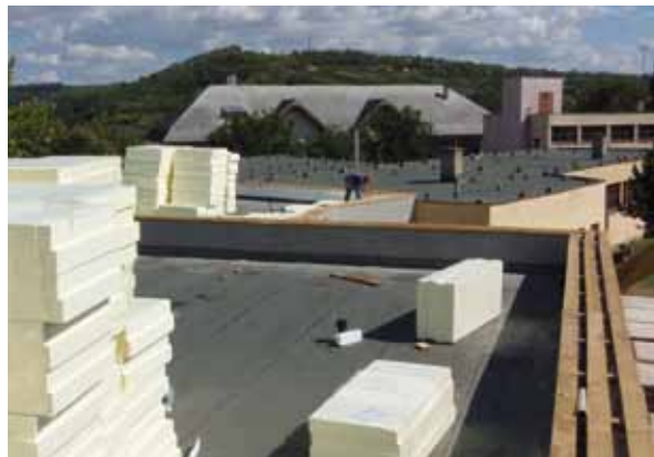
◀◀ Társasház lapostető hőszigetelése, Paks
