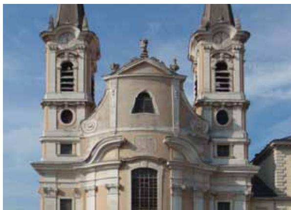
Vízivárosi Templom Esztergomban, melynek tornya és tetőszerkezete Besey László építész és statikus tervező elképzelése alapján újul meg
